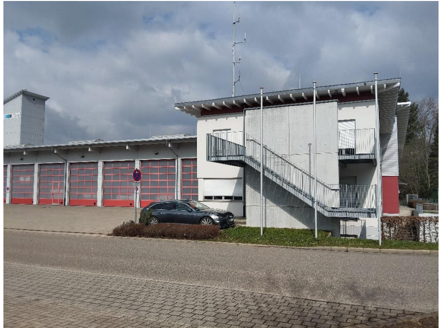
Abbildung 2: Bereich der Fassade an welchen der Anbau erfolgen soll. Das neue Gebäude schließt an den Bereich der Treppe an.
