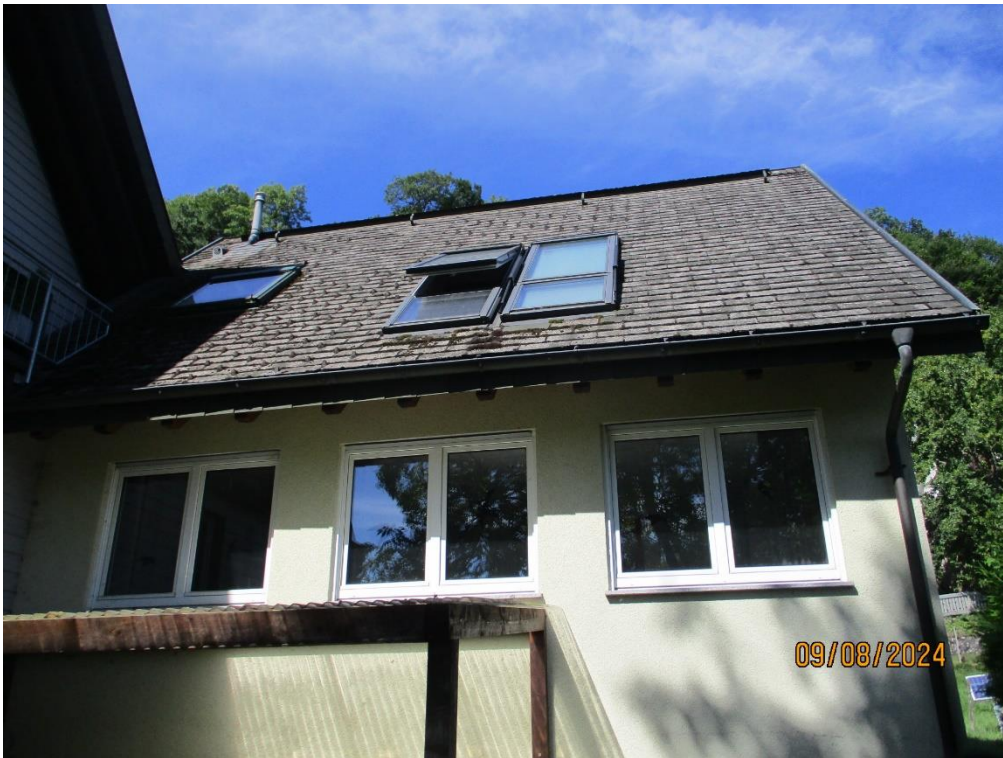
Foto 3: Dach mit verschlossenem Lüftungziegel.
