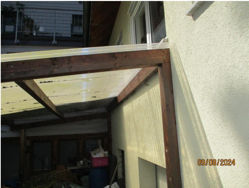
Foto 9: Überdachung ohne erkennbare Strukturen, Blickrichtung Südwesten.
