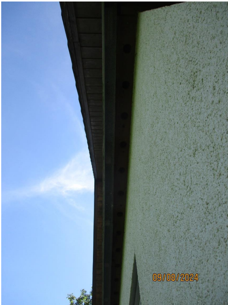
Foto 5: Nach Norden ausgerichtete Hausfassade mit verschlossenen Lüftungsspalten.
