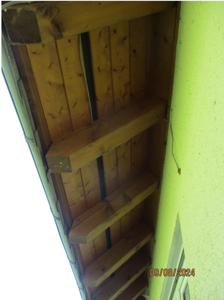
Foto 6: Dachvorsprung mit Gittern verschlossenen Spalten.
