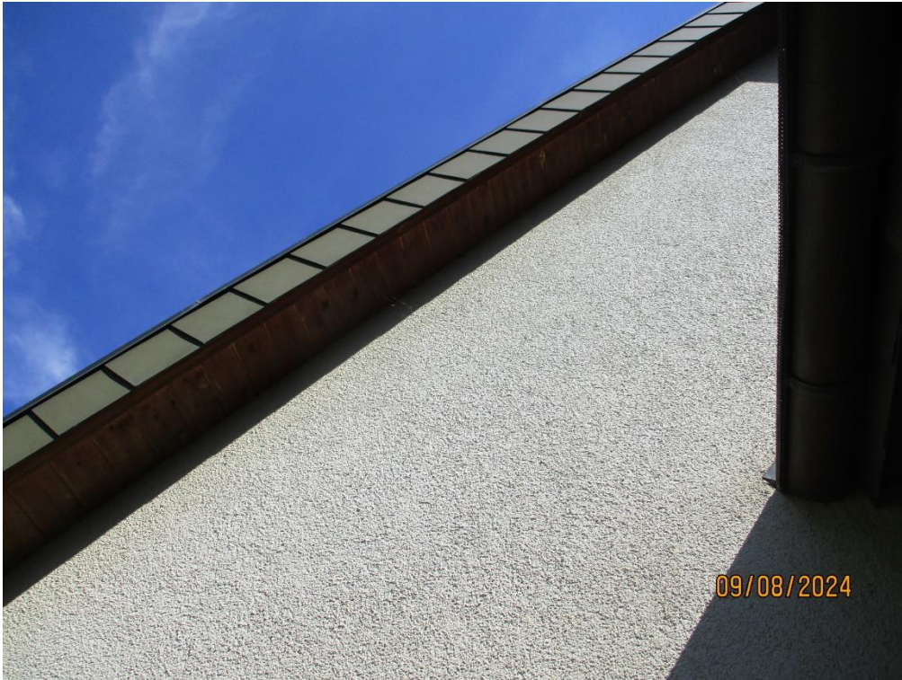
Foto 7: Dachvorsprung ohne erkennbare Strukturen, Blickrichtung Norden.
