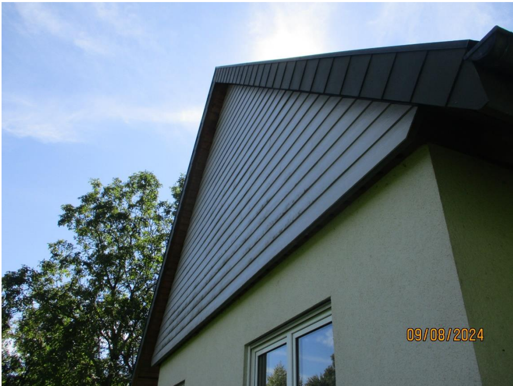
Foto 4: Nach Norden ausgerichtete Fassade mit Holzvertäfelung ohne erkennbare Strukturen
