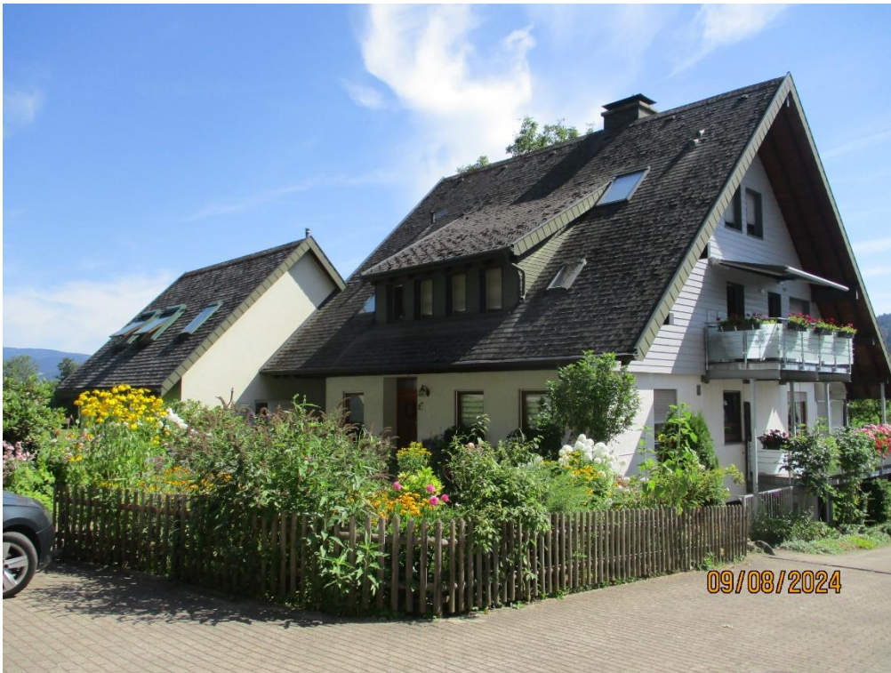
Foto 1: Betroffene Gebäude, Blickrichtung Osten. Das nördliche (hintere) Bürogebäude soll nun aufgestockt und um 2 m erweitert werden.
